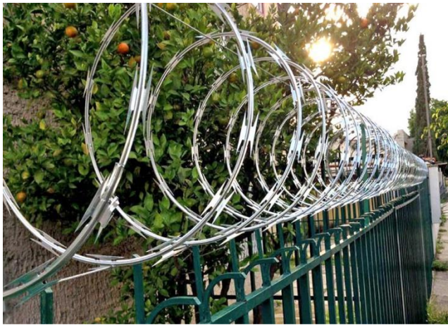
Instalación alambre navaja 18"
