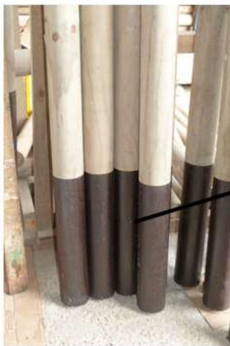
50 cm de revestimiento Underseal 3M, para contrarrestar el efecto de quiebre, causado por el exceso de humedad existente en nuestro clima.
